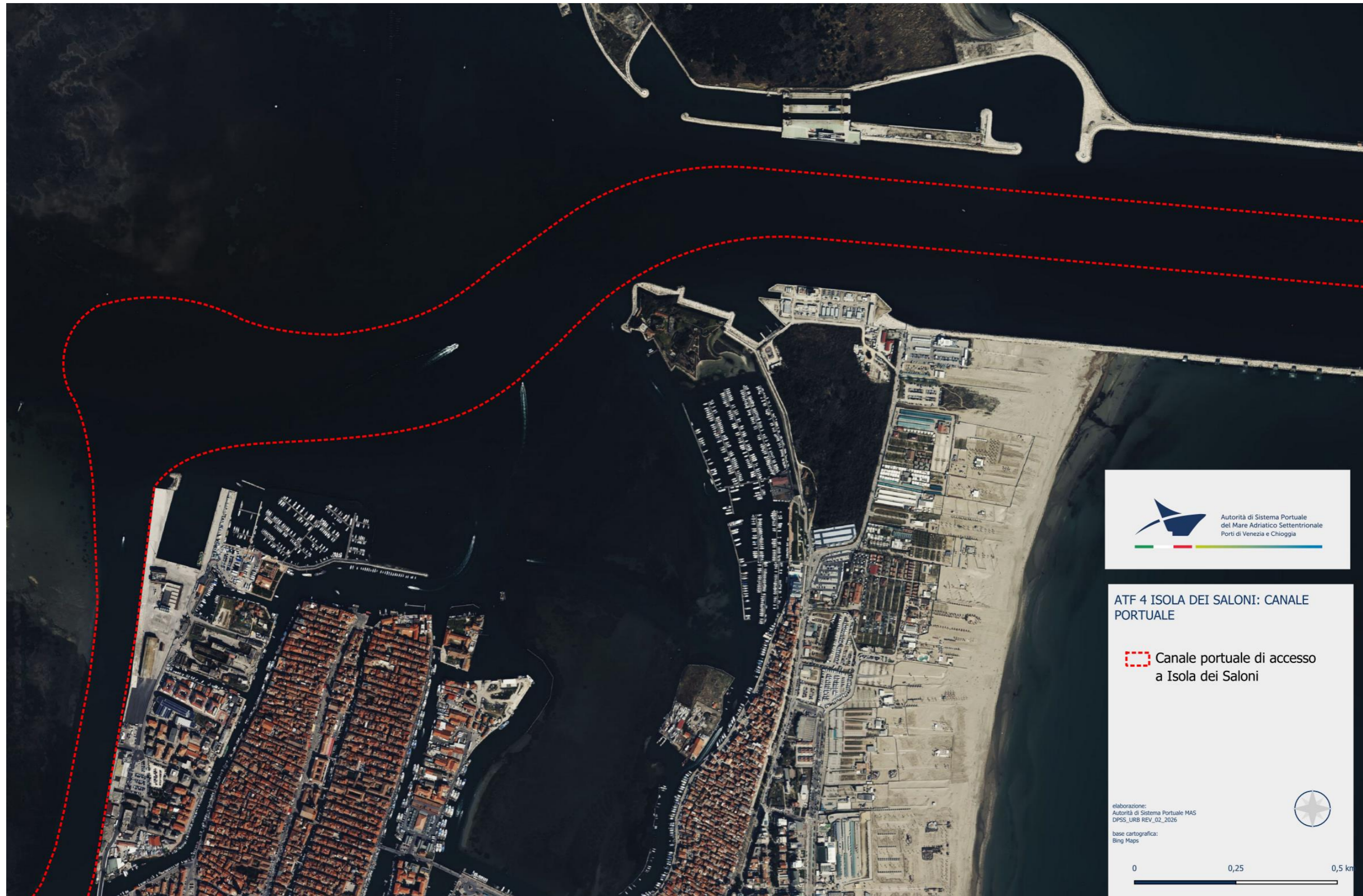
Figura 24: ATF4 Isola dei Saloni: riprofilatura canale di accesso fino all'Isola dei Saloni
